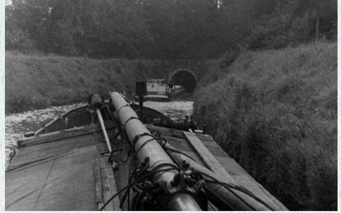
Voor een tunnel in het Canal des Ardennes.
